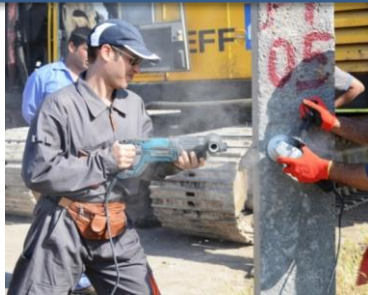
آماده سازی شمع جهت نصب سنسورها
